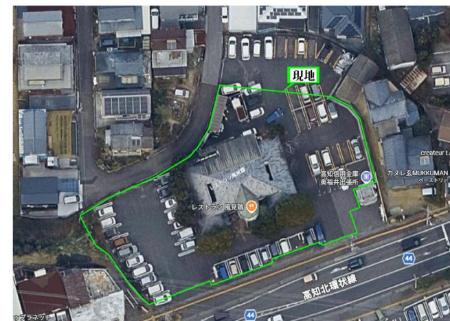
敷地外観、北公道より撮影
